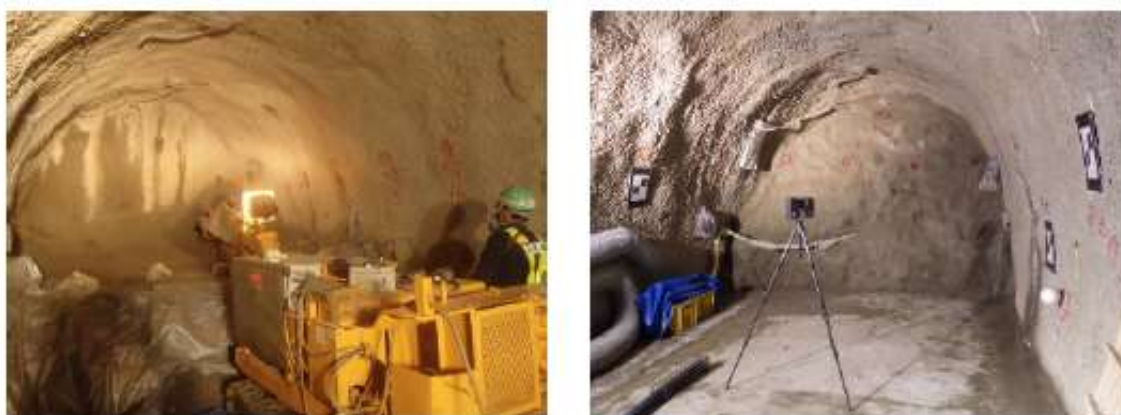
図 7 埋め戻し試験の様子(右は 3D スキャナーによる坑道内側形状の計測)
