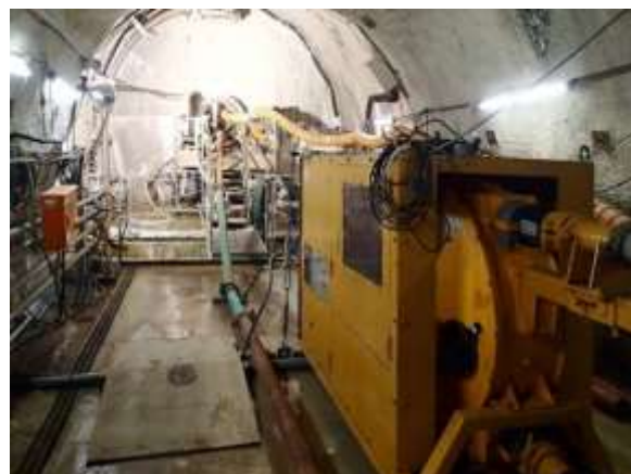
深度500m冠水坑道への埋め戻し材の充填 (手前の黄色の装置は埋め戻し材の圧送装置)
