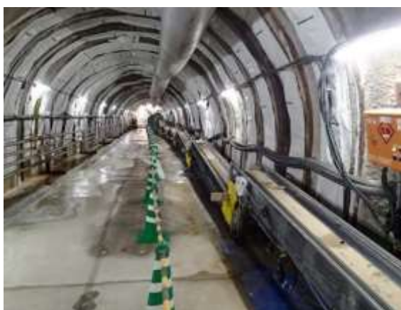
埋め戻し材(砂)の運搬 (深度500m研究アクセス北坑道)
